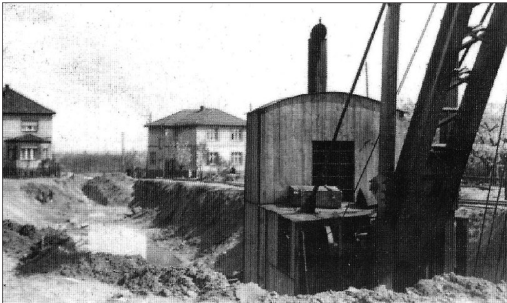
Bild vom Bau des Bahnaußenrings 1951 in Höhe Alemannenstraße.
