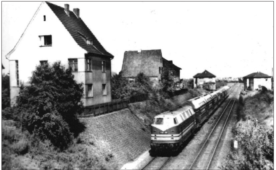
Der Bahnaußenring 1970 in Höhe der Preußenstraße, deutlich tiefer als das Straßenniveau.
